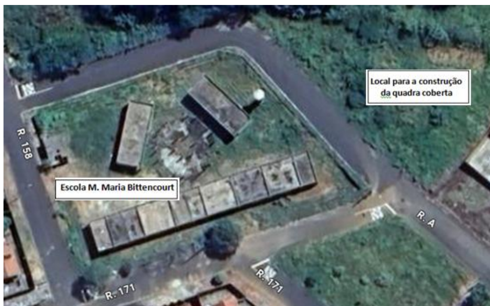
FOTO 01: LOCALIZAÇÃO DA ESCOLA M. M a BITTENCOURT E LOCAL DA OBRA
