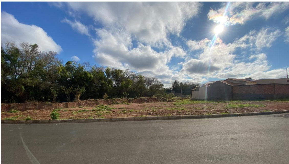
FOTO 05: TERRENO DO LOCAL DA OBRA
