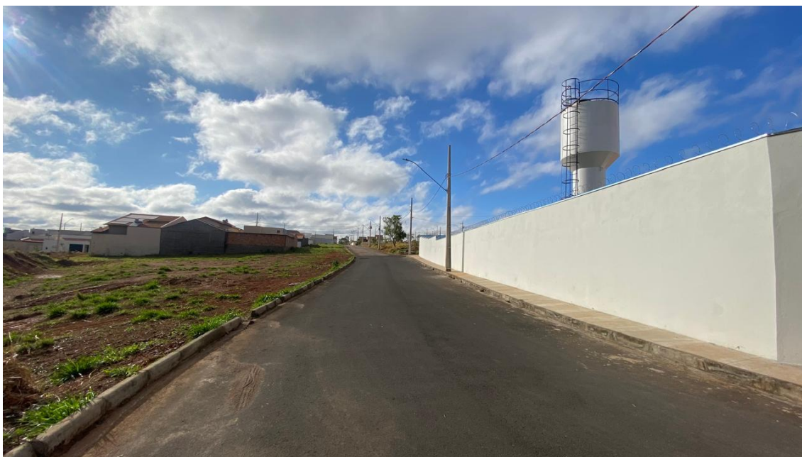
FOTO 04: LOCAL DA OBRA À ESQUERDA E VISTA LATERAL DA ESCOLA M. Mª BITTENCOURT
