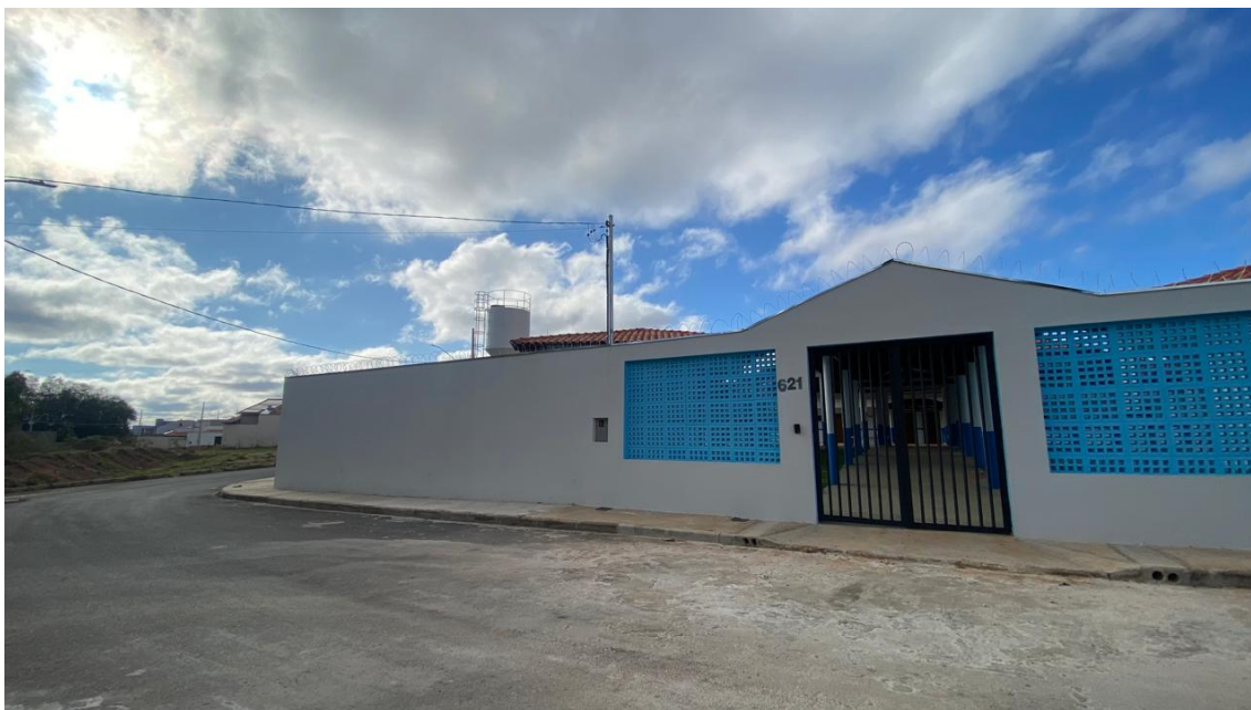
FOTO 03: VISTA FRONTAL DA ESCOLA M. Mª BITTENCOURT E LOCAL DA OBRA À ESQUERDA
