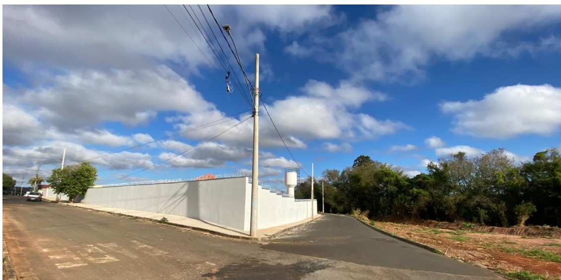
FOTO 08: LOCAL DA OBRA À DIREITA E VISTA LATERAL/FUNDOS DA ESCOLA M. Mª BITTENCOURT
