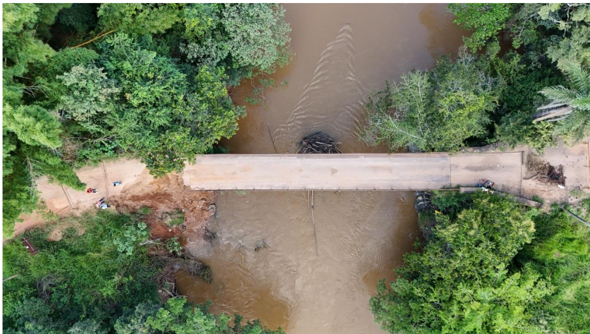
FOTO 04 – Vista superior da ponte existente sobre o Rio Misericórdia, mostrando a extensão da travessia e as condições do entorno.
