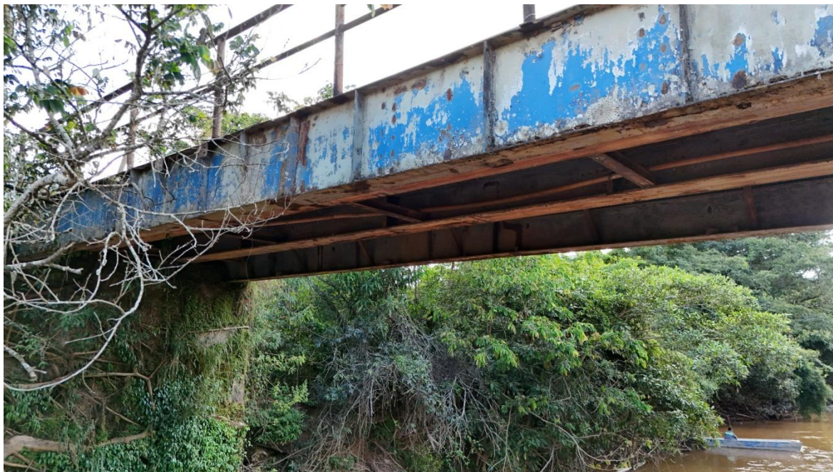
FOTO 06 – Vista lateral/inferior da estrutura existente, registrando a condição aparente dos elementos metálicos e do sistema de apoio.
