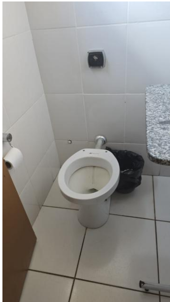
Figura 47: Banheiro sala ginecológica corredor 03
