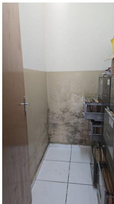
Figura 43: Sala arquivo corredor 03
