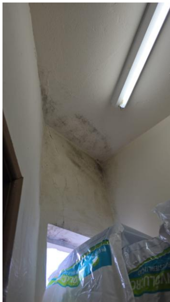
Figura 61: Almojarifado corredor interno
