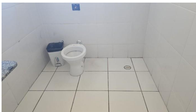
Figura 9: Banheiro feminino recepção
