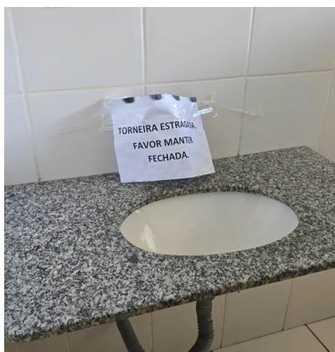
Figura 8: Banheiro masculino recepção
