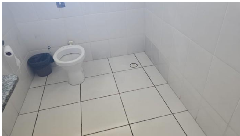
Figura 7: Banheiro masculino recepção
