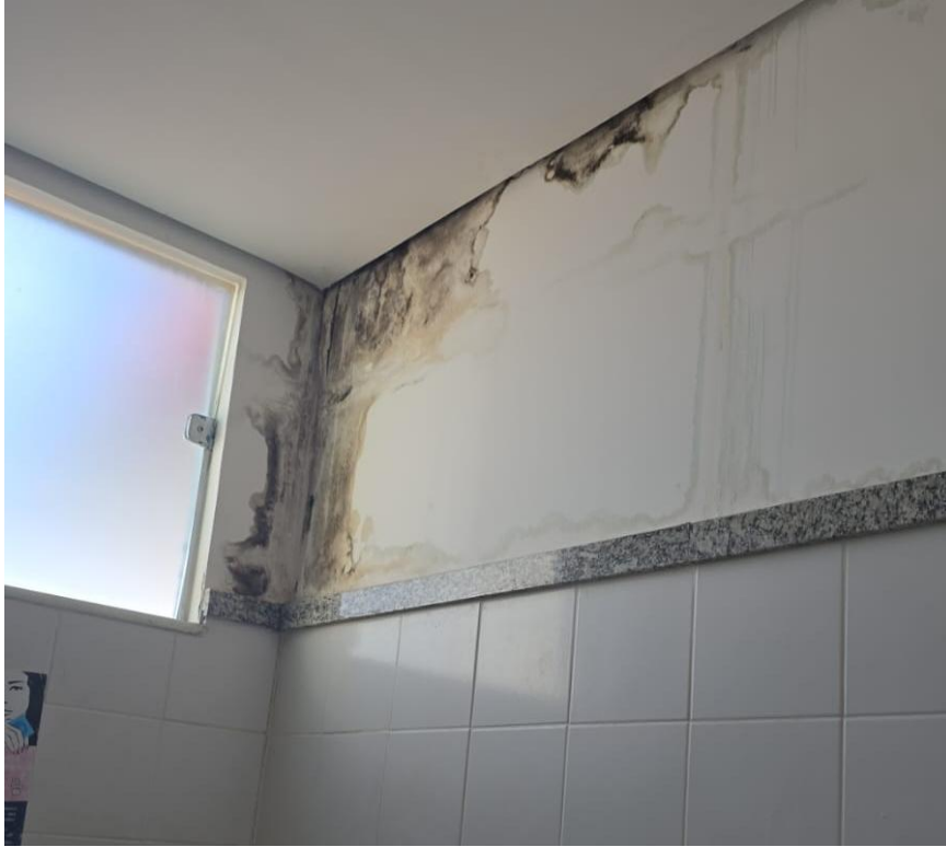
Figura 10: Banheiro Feminino Recepção
