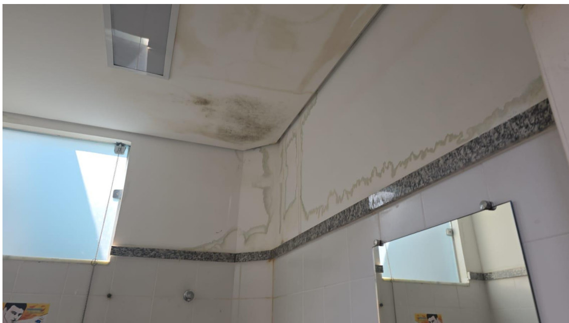
Figura 9: Banheiro Feminino Recepção
