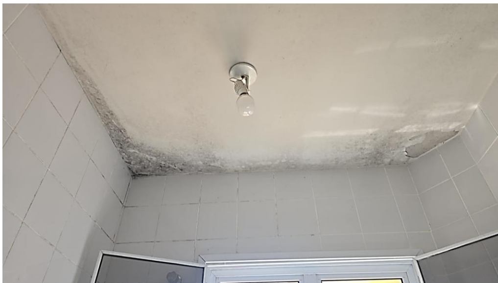
Figura 32: Banheiro feminino Recepção
