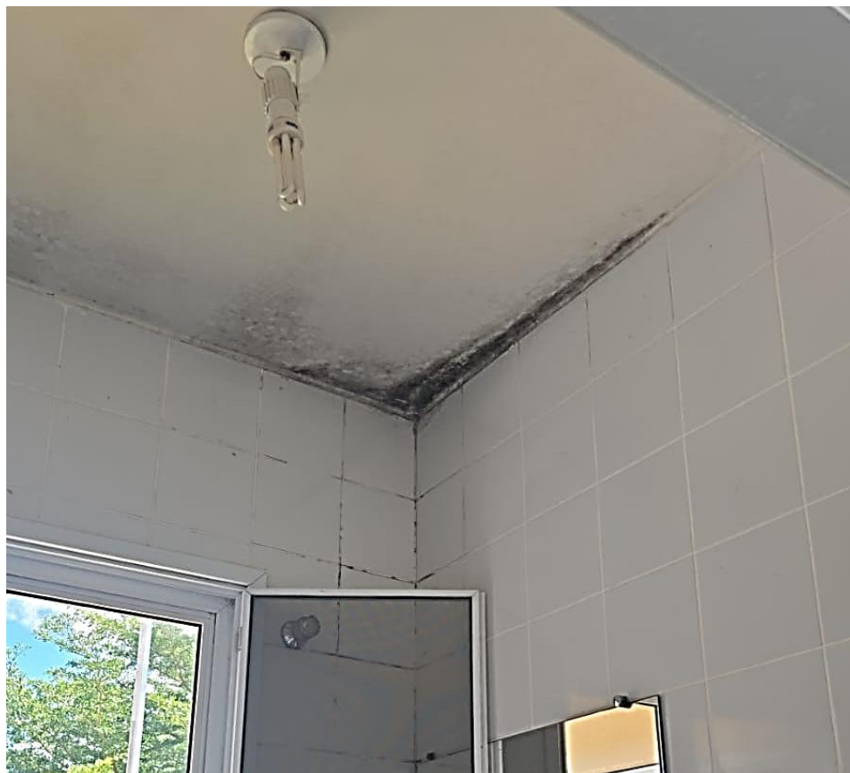
Figura 31: Banheiro masculino Recepção
