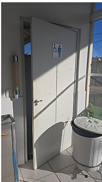
Figura 7: Banheiro Masculino Recepção
