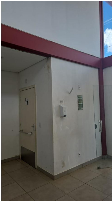
FOTO 08: LOCAL DA OBRA
