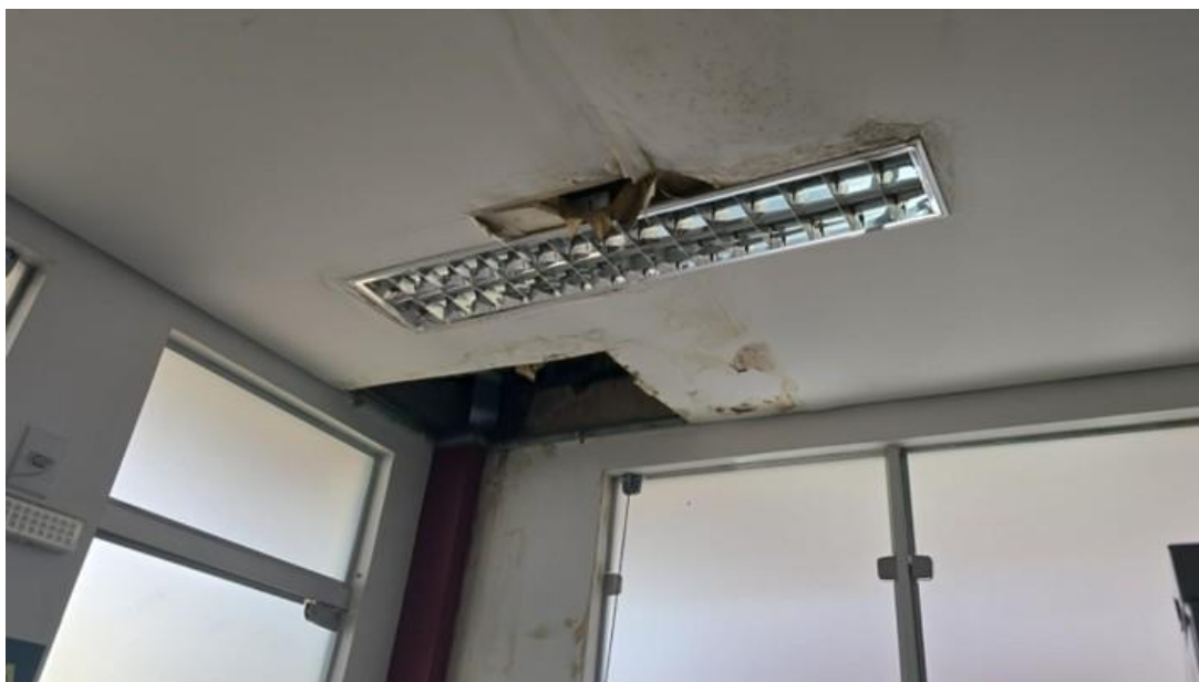
FOTO 11: LOCAL DA OBRA
