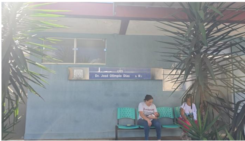
FOTO 01: LOCALIZAÇÃO DA OBRA
