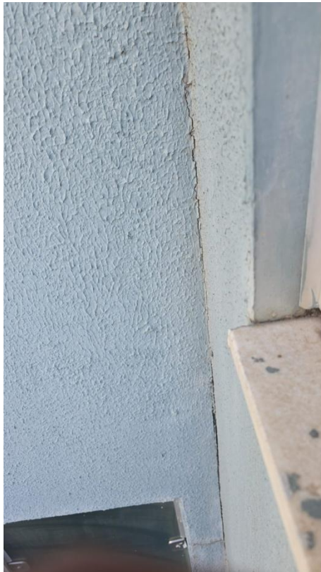
FOTO 04: LOCAL DA OBRA
