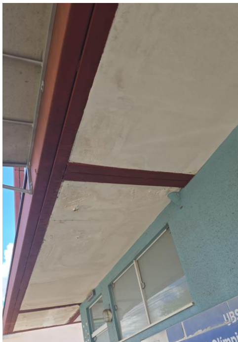
FOTO 02: LOCAL DA OBRA
