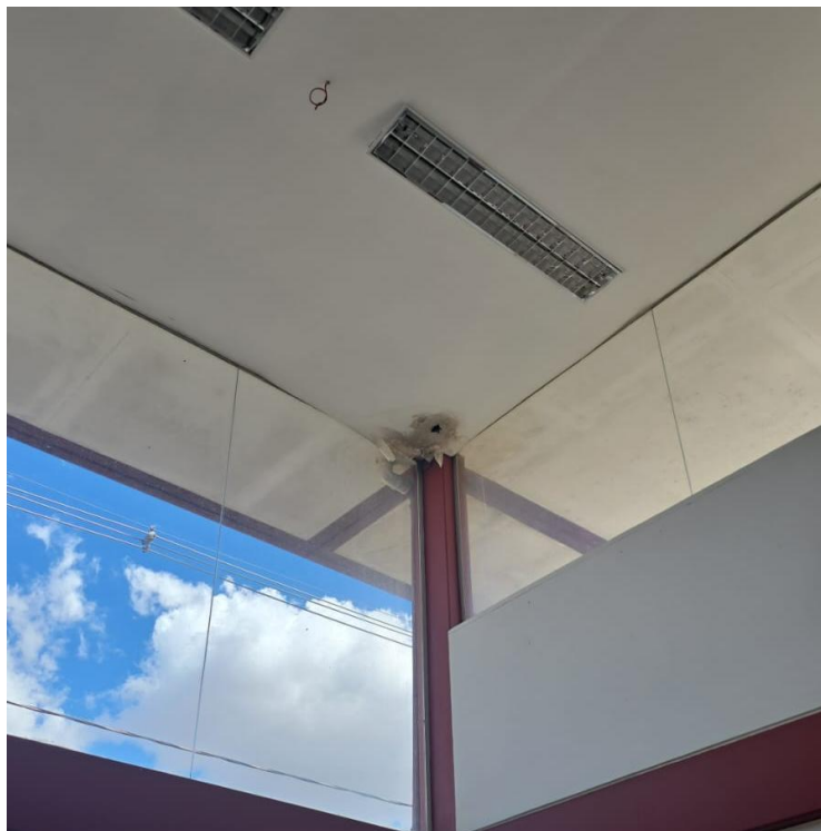
FOTO 06: LOCAL DA OBRA
