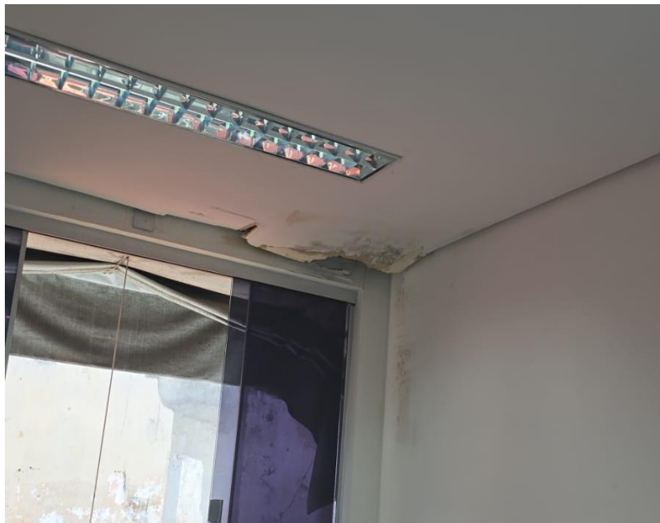
FOTO 12: LOCAL DA OBRA
