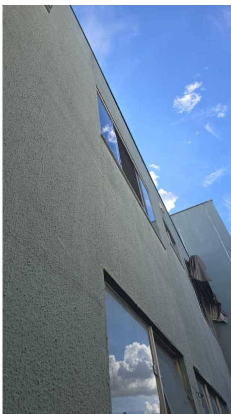
FOTO 13: LOCAL DA OBRA
