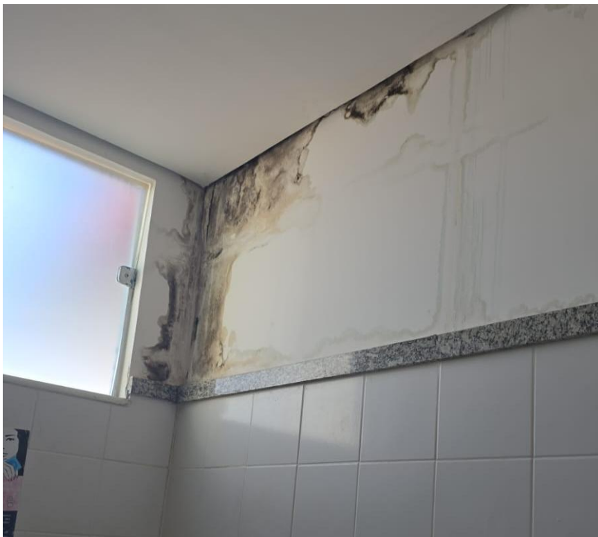
FOTO 10: LOCAL DA OBRA
