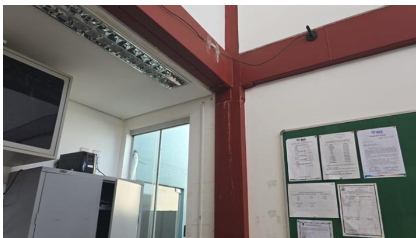
FOTO 07: LOCAL DA OBRA
