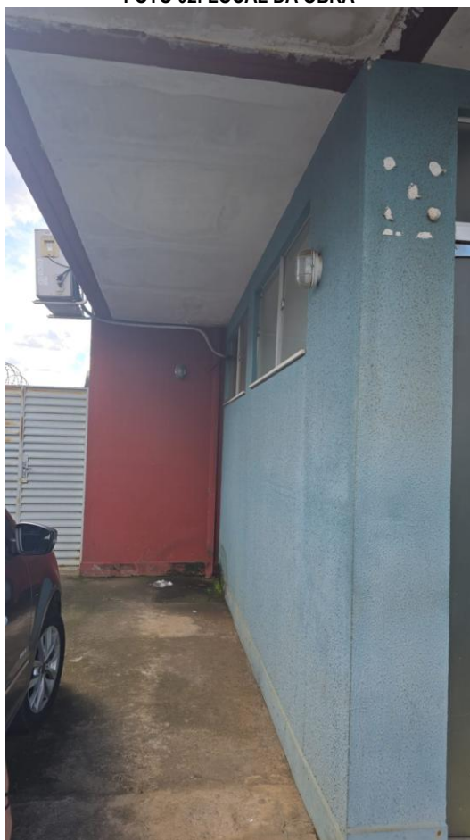
FOTO 03: LOCAL DA OBRA
