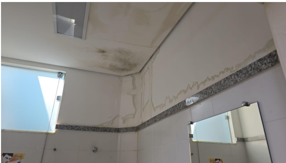
FOTO 09: LOCAL DA OBRA
