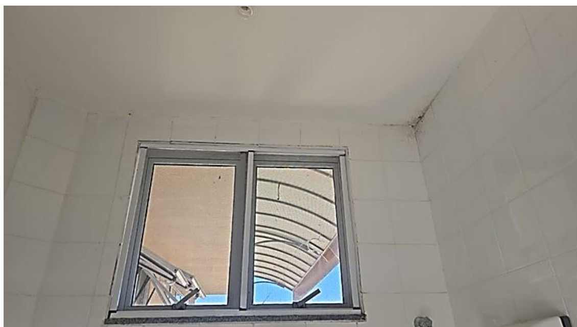
FOTO 05: BANHEIRO MASCULINO RECEPÇÃO
