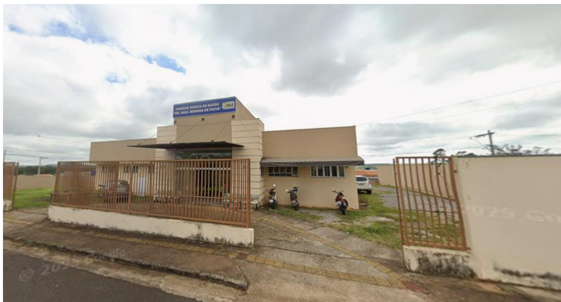
FOTO 01: LOCALIZAÇÃO DA OBRA
