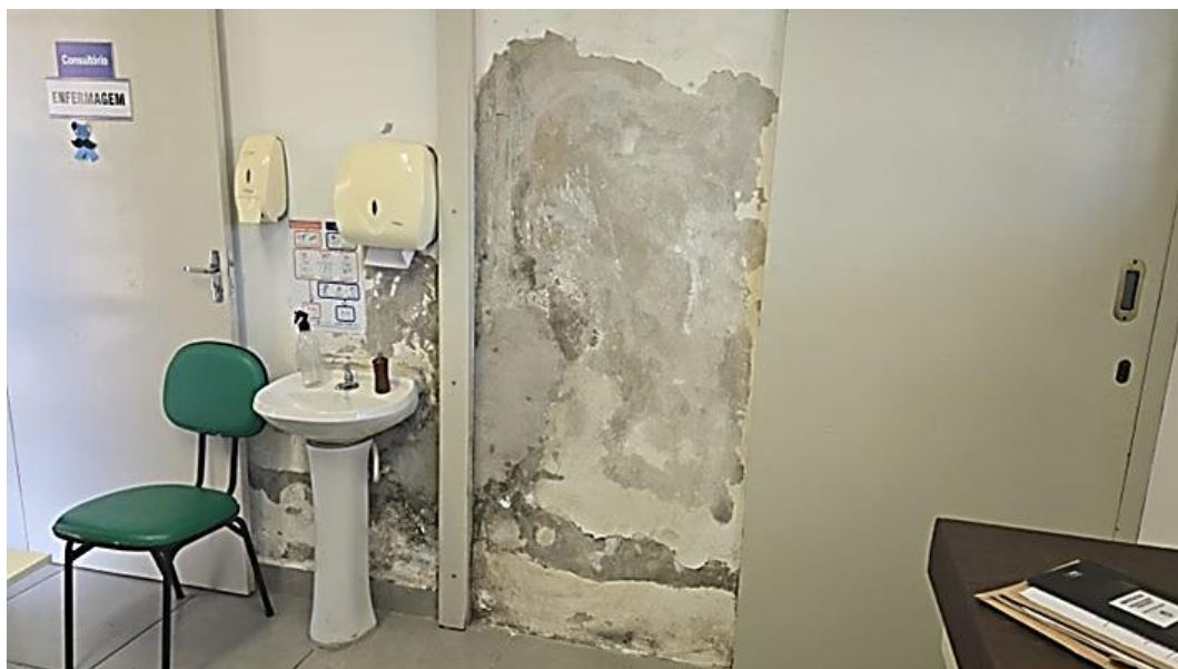
FOTO 11: LOCAL DA OBRA
