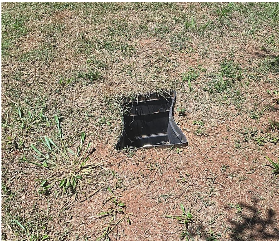
FOTO 02: LOCAL DA OBRA
