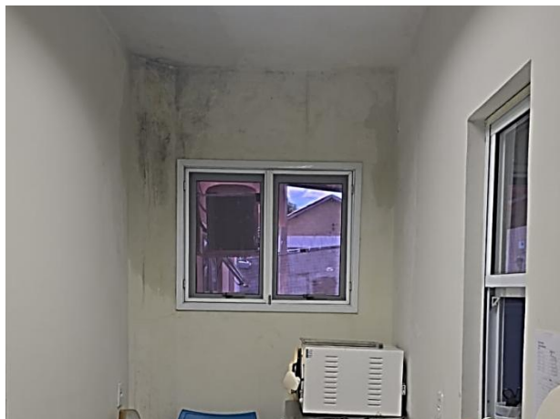
FOTO 08: LOCAL DA OBRA
