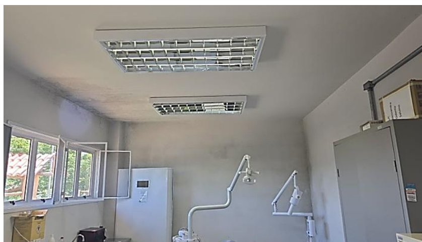
FOTO 10: LOCAL DA OBRA
