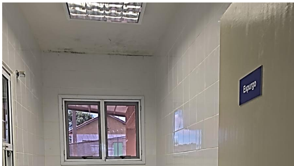
FOTO 09: LOCAL DA OBRA
